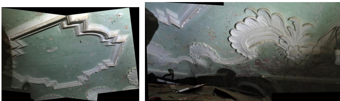
Рис. 8, 9. Парадное помещение 1-го этажа палат Первышева, накрытое зеркальным сводом с распалубками и лепным декором геометрических и растительных орнаментов, характерных для периода барокко. Фото Е. В. Холодовой. Июль 2022 г.
